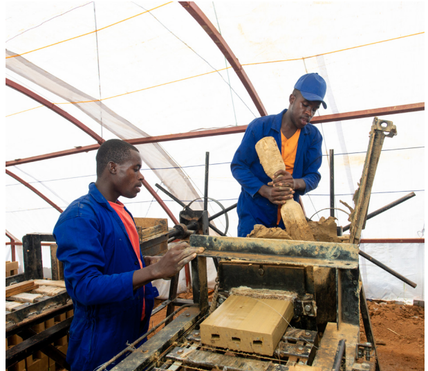
Les machines manuelles d'origine locale sont gérées par des équipes mobiles qui peuvent être déployées sur un chantier de construction.
