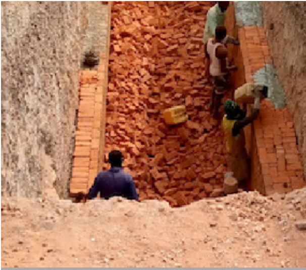
Four à tranchée en construction. Les briques cuites recyclées servent de surfaces isolantes pour les murs et les sols.
