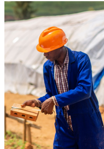
Maçon vérifiant les dimensions de la brique
