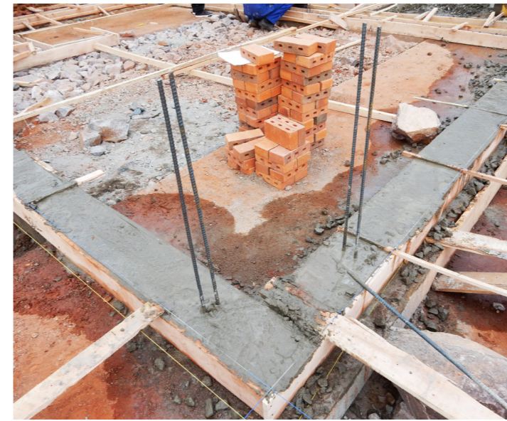
Poutre de libage et les aciers verticaux en attente.
