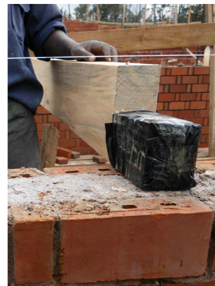
Tête de poutre en bois imperméable à l'eau
