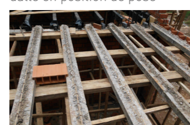
Blocs de hourdis placés entre les nervures
