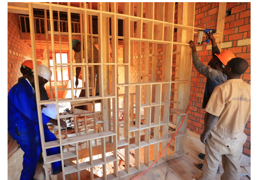
Cloison à ossature bois en cours de construction
