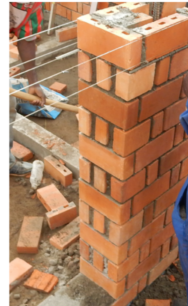
Côté mur RLB avant une porte
