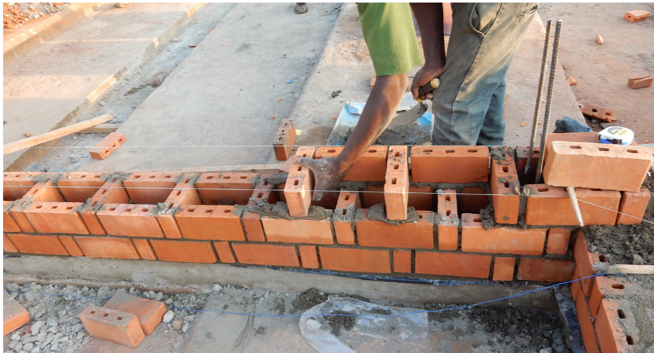
Construction d'une maçonnerie de mur en Row Lock Bond
