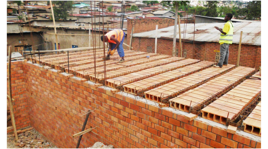
Travaux de préparation d'une dalle Hourdis coulée sur place
