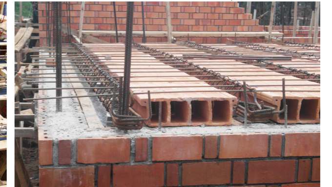
Détail de l'armature et des blocs des nervures de dalle hourdis coulée sur place
