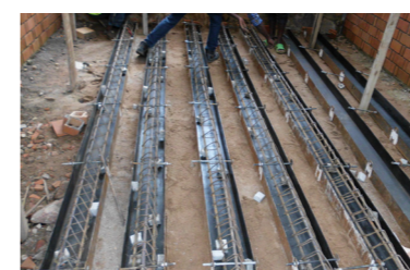
Coffrages de nervures de la dalle
