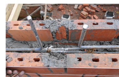
Détail des barres d'attente des poutres d'ancrage
