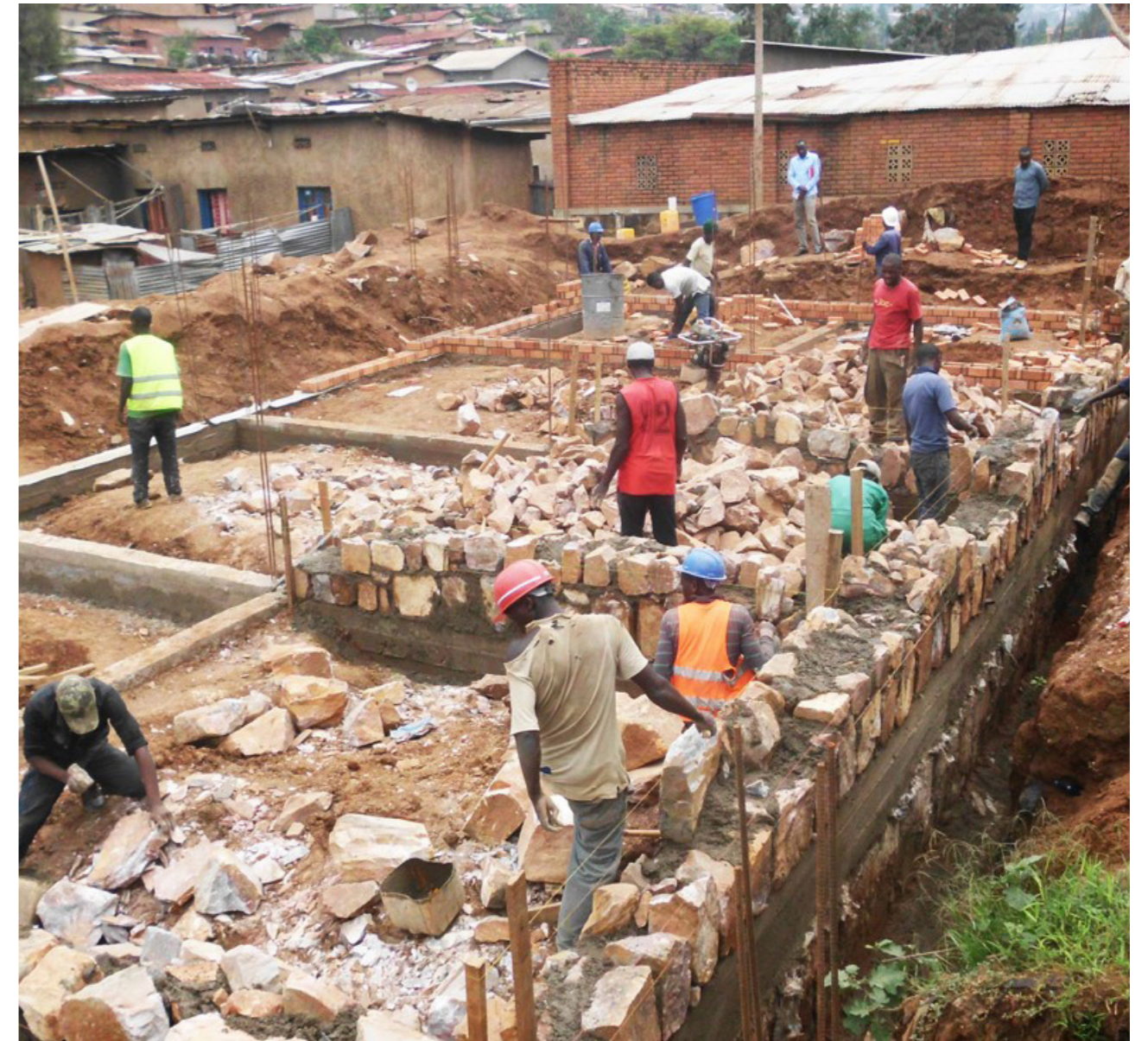
Construction d'un mur de fondation en maçonnerie de pierre
