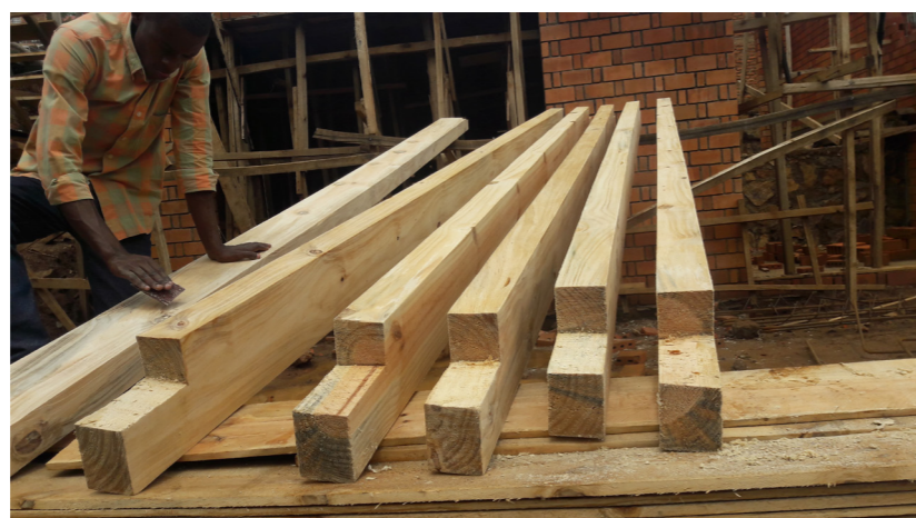
Poutres en bois poncées et traitées avant l'installation
