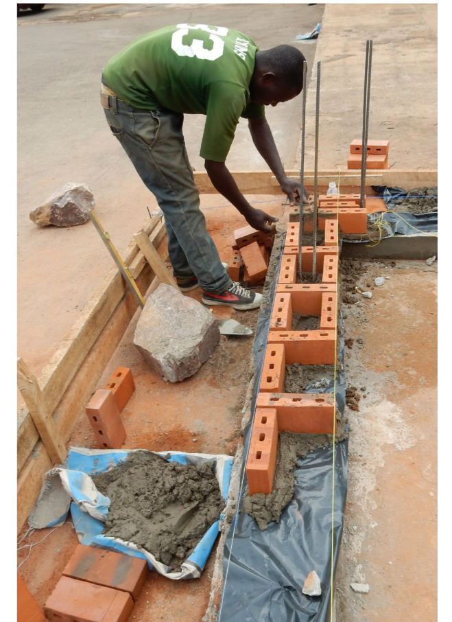
Première rangée de pose de mud RLB
