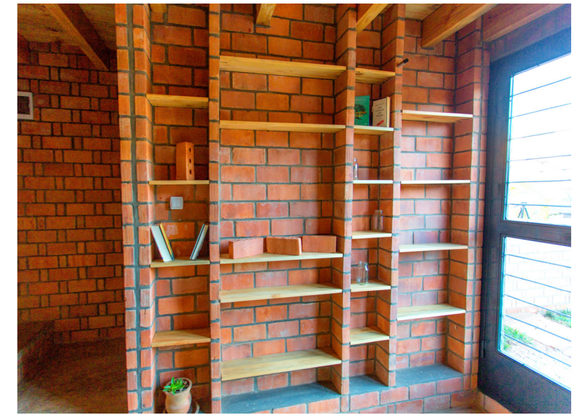
Cloison intérieure en briques de 5,5x10x21cm avec contreforts et étagères encastées
