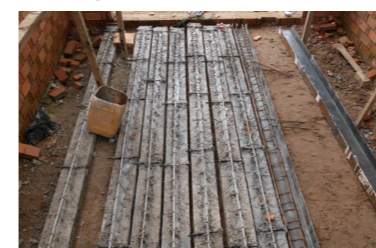
Muricement des nervures de la dalle sur place
