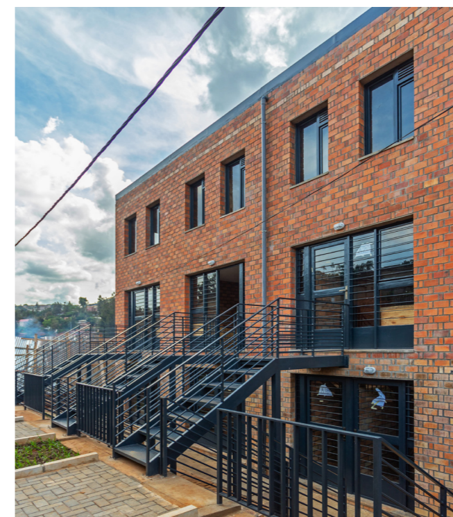
Escaliers extérieurs en métal
