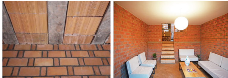
Hourdis sous-face de la dalle Sous-face de la dalle à hourdis enduite
