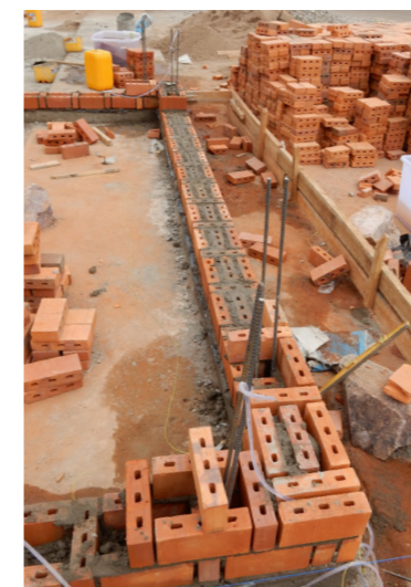
Première pose de brique
