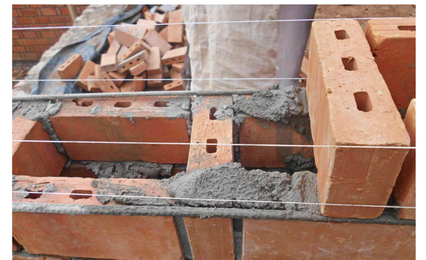
Tige d'acier utilisée comme calibre pour contrôler l'épaisseur du joint
