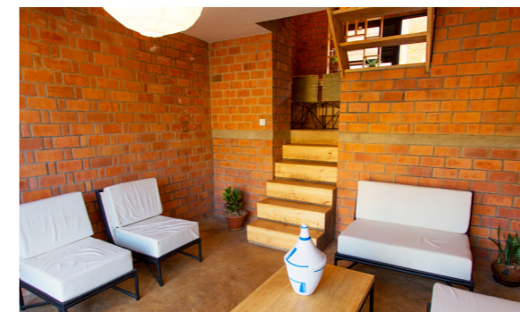
Exemple d'escalier en BA. + bois reliant des niveaux intermédiaires/niveaux plancher
