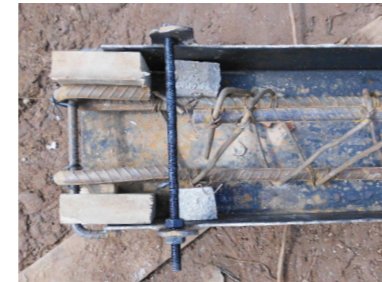
Détail du bout de la poutre préfabriquée
