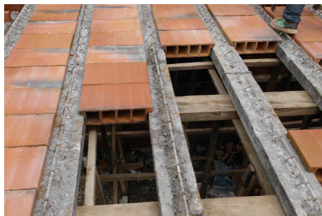
↑ Blocs de Hourdis placés entre les côtes
