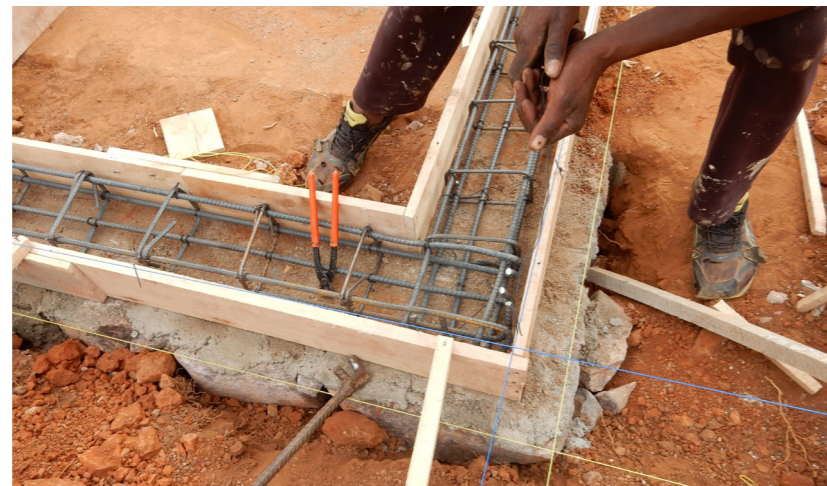
Exemple de coffrage de la poutre de libage
