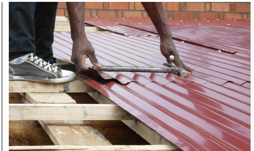
des tôles ondulées installées avec un chevauchement minimum de 15 cm
