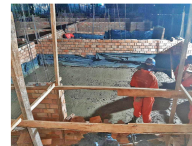
En haut et en bas : activités de coulage de béton et préparation des sols
