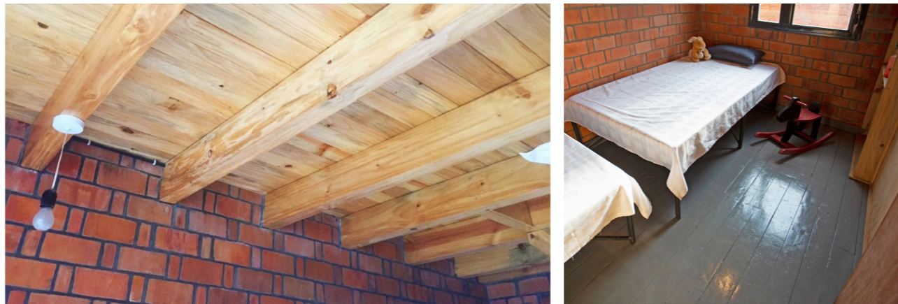
Un plancher suspendu en poutres de pin et planches de pin T&G Planches de plancher vernies
