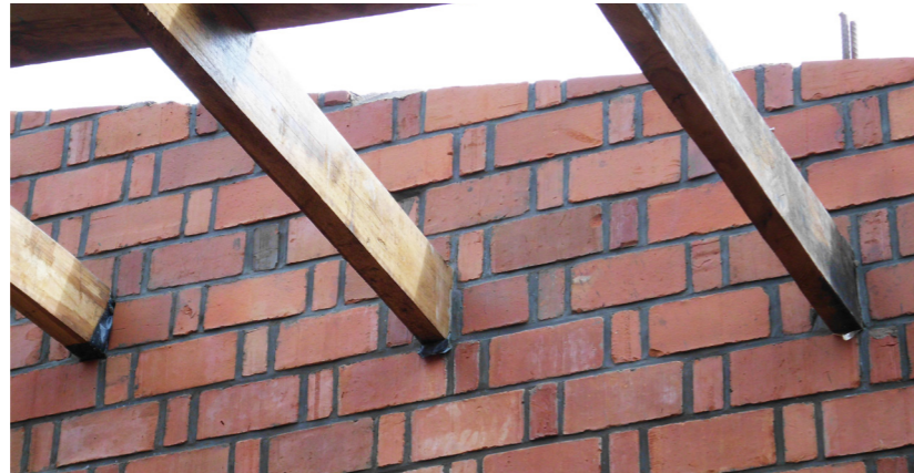
Détail des poutres du toit
