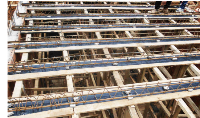
Renforts de nervures pour dalle Hourdis coulée sur place, positionnés au-dessus du coffrage
