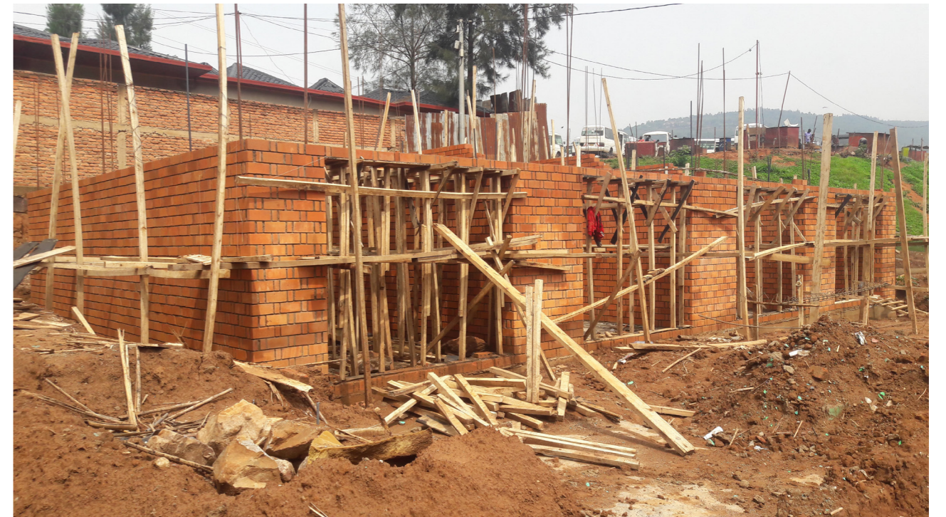
Plusieurs ouvertures sur la façade principale d'un bâtiment RLB
