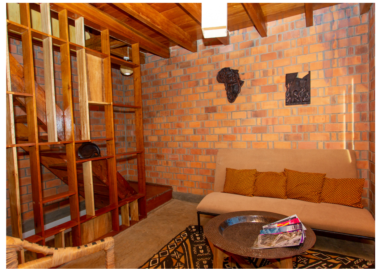
Ci-dessus et ci-dessous : exemples de planchers suspendus en bois dans un projet construit par RLB à Bukavu.
