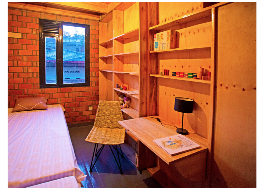
Cloison à ossature bois avec étagères et bureau intégrés
