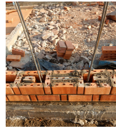
Barres d'armatures en attente fixées à la poutre de libage
