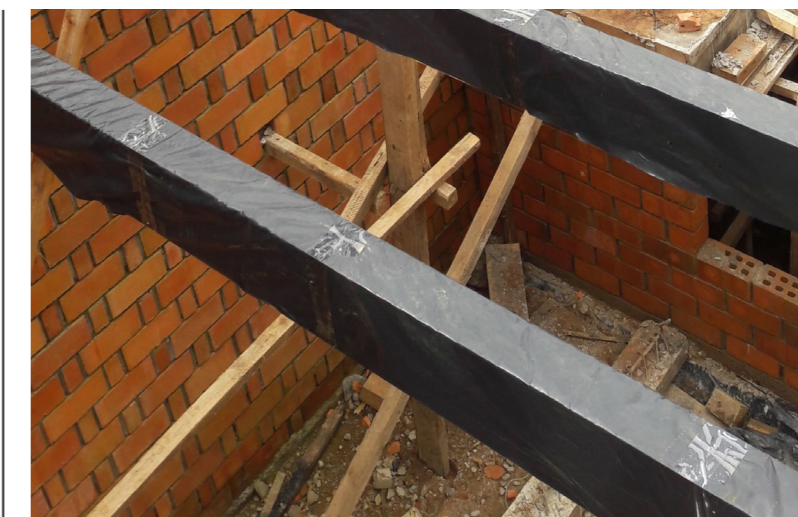
Vue détaillée de la connexion entre la poutre en bois et le mur RLB.
