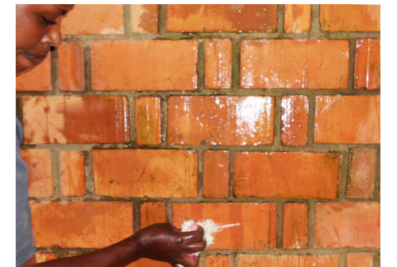
Le nettoyage des murs RLB se fait à l'eau et au vinaigre.
