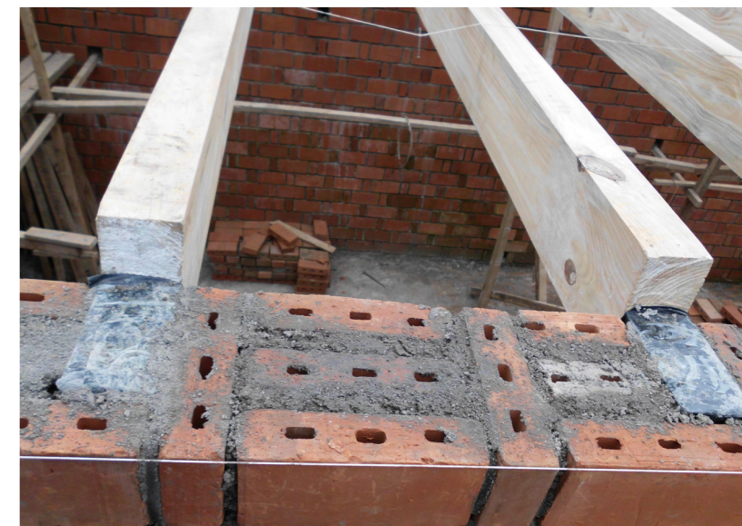
Vue détaillée de la connexion entre la poutre en bois et le mur RLB.
