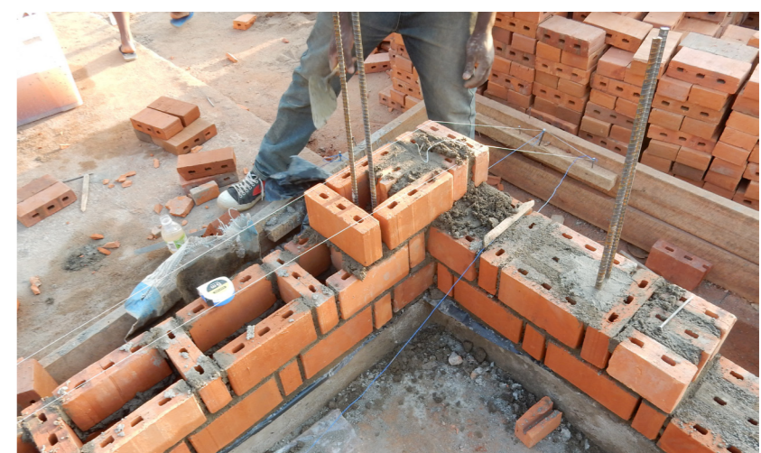
Renforcement de murs d'intersection en RLB
