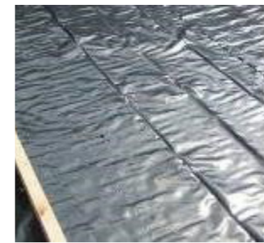
Membrane anti-humidité posée sur la surface compactée du remblais
