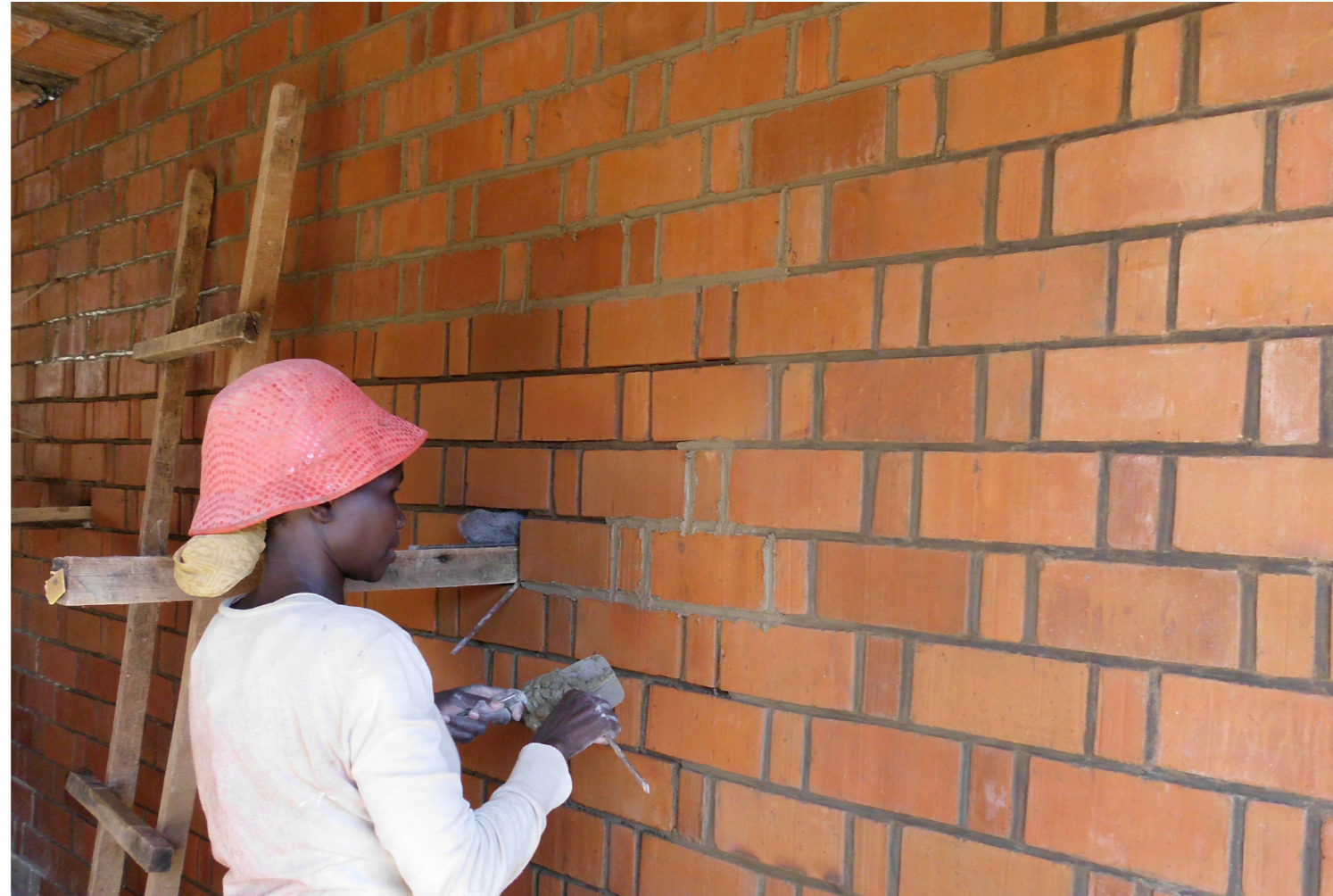
Travaux de jointoiment des murs RLB
