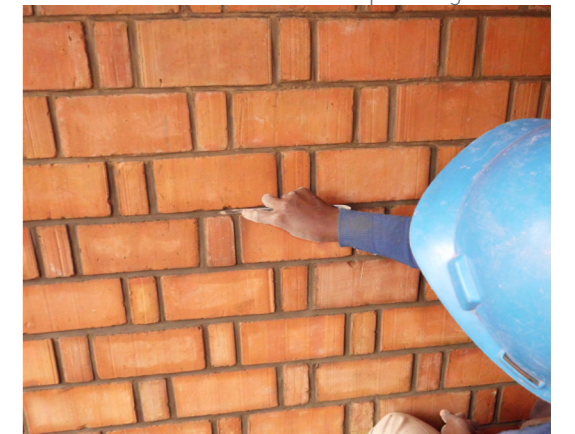
Le nettoyage des murs RLB se fait à l'eau et au vinaigre.
