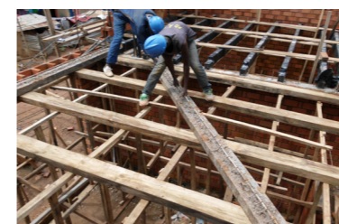
Hissage de la nervure de la dalle en position de pose
