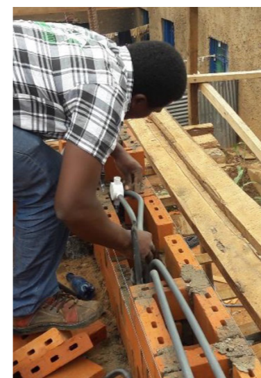
Un électricien travaillant à l'installation de conduits dans les cavités de la RLB
