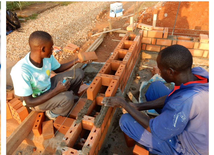
Construction d'une maçonnerie de mur en Row Lock Bond
