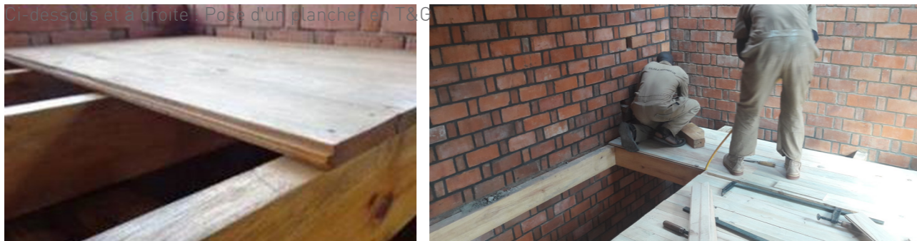
Ci-dessous et à droite : Pose d'un plancher en T&G
