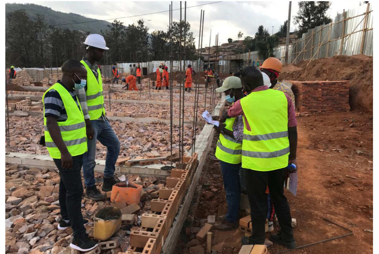
Une équipe de supervision vérifiant le tracé de la première rangée du RLBt
