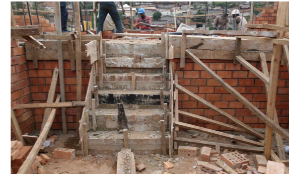
Exemple d'escalier en BA. + bois reliant des niveaux intermédiaires/niveaux plancher
