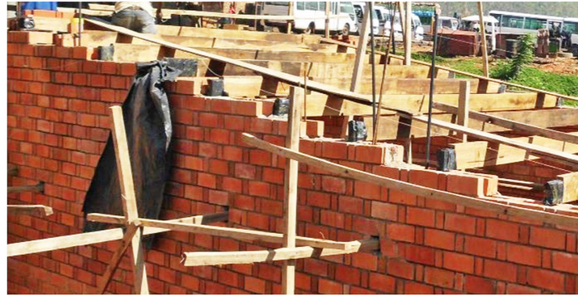
Poutres de bois du toit en place avant la poursuite de la construction du mur
